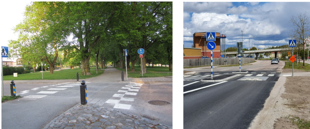
Figur 6. Förhöjd genomgående passage och vägkuddar i Köping. Foto: NTF.
