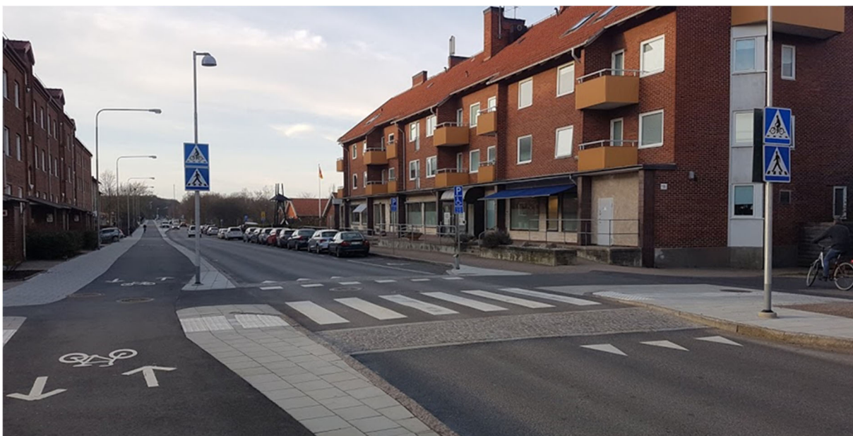
Figur 5. GCM-passager på Jönköpingsgatan i Helsingborg före och efter åtgärd. Foton från Google Maps och Helsingborgs kommun.
